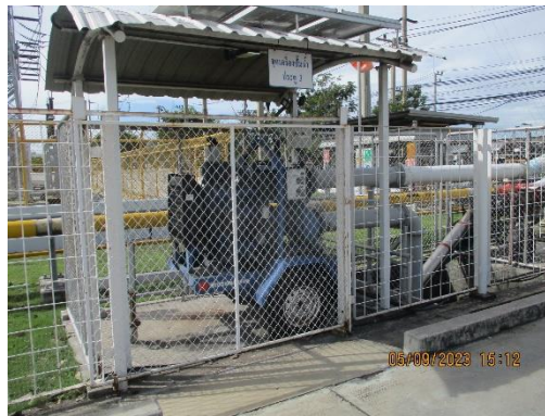
รูปที่ 15 การติดตั้งปั้มนสูบน้ำป้องกันน้ำท่วม
