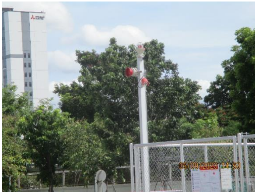
รูปที่ 52 ระบบสัญญาณแจ้งเหตุเพลิงไหม้อัตโนมัติ และอุปกรณ์ดับเพลิง บริเวณพื้นที่จัดเก็บถังก๊าซไฮโดรเจน
