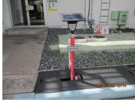
รูปที่ 14 การติดตั้งเสาวัดระดับน้ำในรางระบายน้ำฝน
