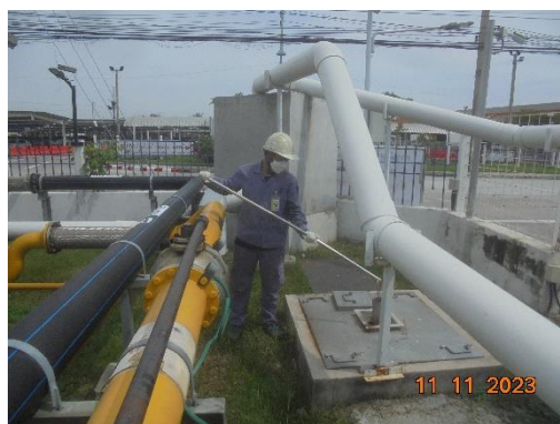
รูปที่ 5 บ่อพักน้ำสุดท้ายก่อนปล่อยสู่ระบบบำบัดน้ำเสียส่วนกลางในนิคมอุตสาหกรรม
