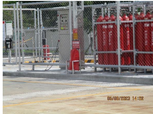
รูปที่ 52 ระบบสัญญาณแจ้งเหตุเพลิงไหม้อัตโนมัติ และอุปกรณ์ดับเพลิง บริเวณพื้นที่จัดเก็บถังก๊าซไฮโดรเจน
