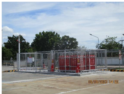
รูปที่ 53 รั้วโพร่งรอบพื้นที่จัดเก็บถังก๊าซไฮโดรเจน
