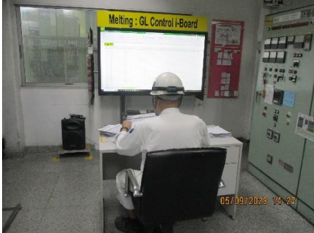
รูปที่ 6 ห้องควบคุม (Control Room) เพื่อลดการสัมผัสเสียงดังของพนักงาน
